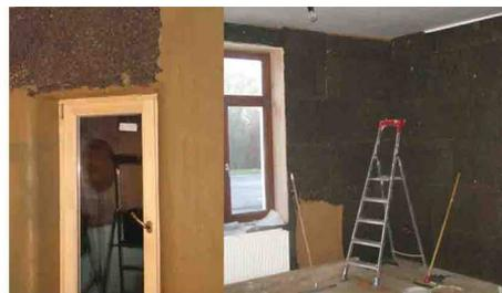
Blocs de chanvre-chaux pour l'isolation par l'extérieur
