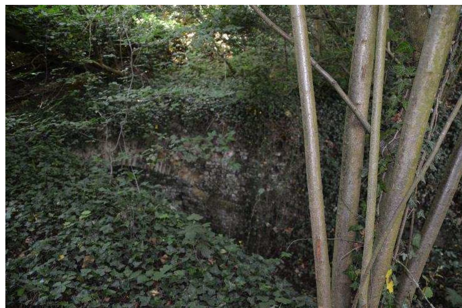
IA9_05. Entrée du passage souterrain, à l'ouest du Jardin Massart (zone 14). Ce passage présente un grand intérêt potentiel comme gîte d'hiver pour les chauves-souris. (Aeolus, 2008)
